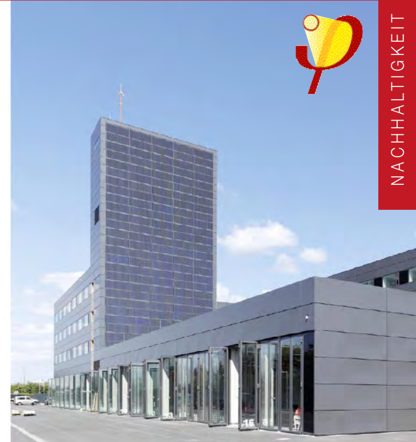
Feuerwache, Heidelberg (Architekten: Kulka /Urbanietz, Köln) Ausgezeichnet mit dem Passivhauszertifikat des Passivhaus-Instituts. Ausgeführt mit WICTEC 50HI Passivhaustauglicher Fassade und WICLINE 77HI Hochisolationsfenster, U w gesamt = 0,8 W/m 2 K
