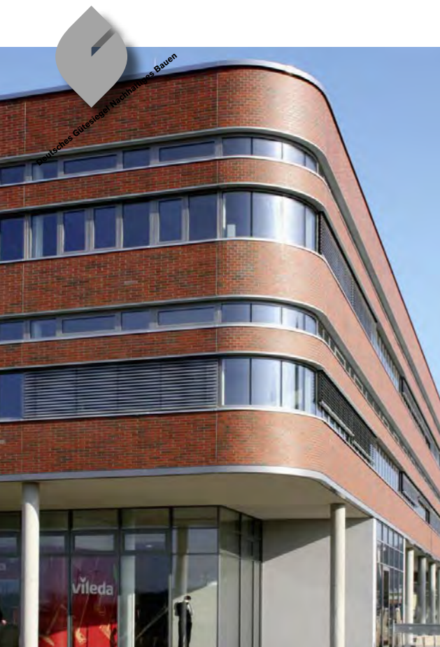
Freudenberg Haushaltsprodukte KG, Weinheim (Baurconsult, Hassfurt) Ausgezeichnet mit dem Gütesiegel in Silber der DGNB. Ausgeführt mit WICTEC 50HI passivhaustauglicher Fassade und WICLINE 77HI Hochisolationsfenster.
