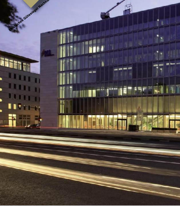
DEG, Köln (JSK Architekten, Düsseldorf) Ausgezeichnet mit dem Gütesiegel in Gold der DGNB. Ausgeführt mit einer elementierten WICONA Verbundfassade.
