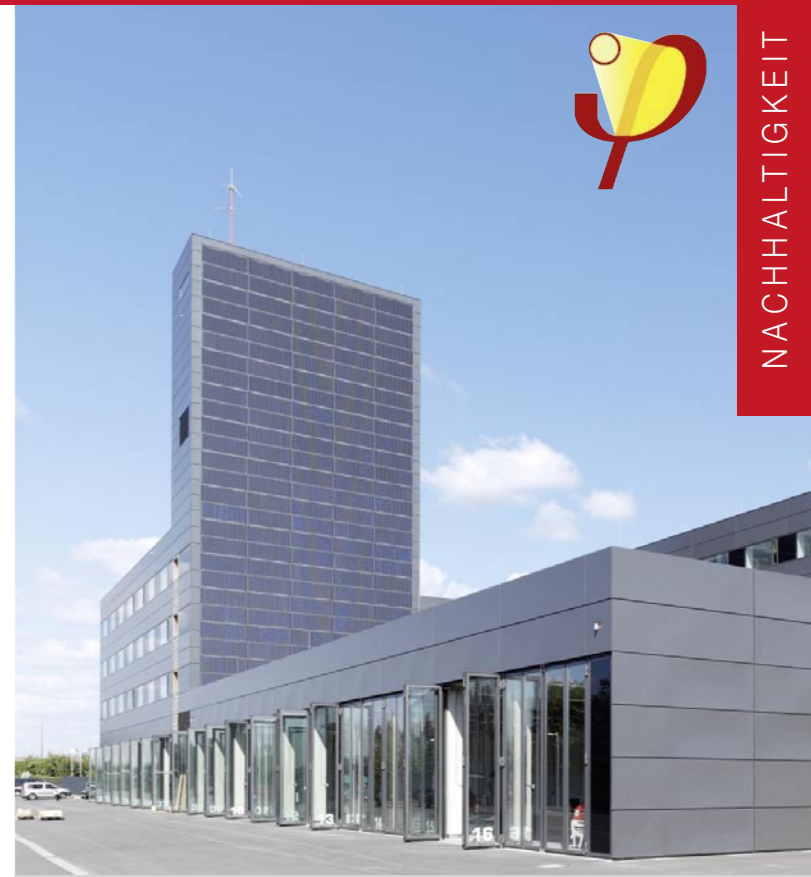
Feuerwache, Heidelberg (Architekten: Kulka /Urbanietz, Köln) Ausgezeichnet mit dem Passivhauszertifikat des Passivhaus-Instituts. Ausgeführt mit WICTEC 50HI Passivhaustauglicher Fassade und WICLINE 77HI Hochisolationsfenster, U w gesamt = 0,8 W/m 2 K.
