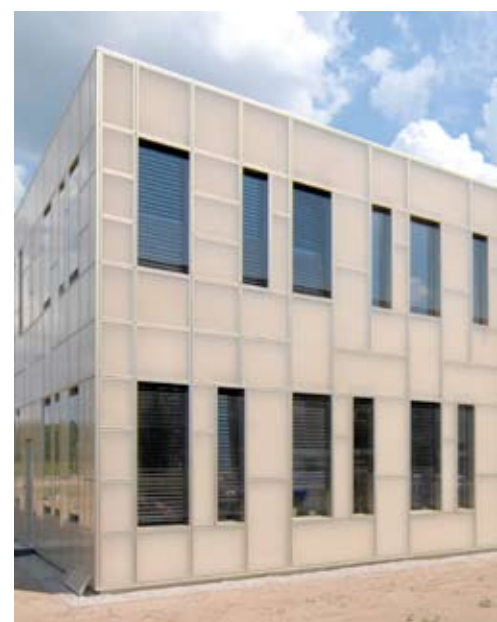
Die opaken Fassadenelemente lassen den massiven Baukörper je nach Lichteinfall durchschimmern und verleihen der Fassade einen Eindruck von Tiefe und Leichtigkeit zugleich
